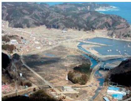
防潮堤が流された震災後の田老
